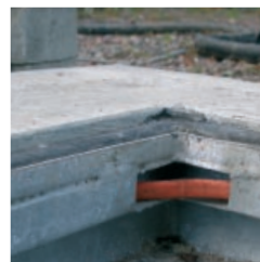
3. Varmekabel – sikrer mod frost og isdannelse.
