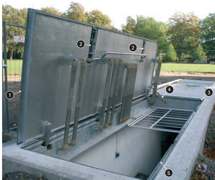
2. Københavnslås – en enkel og funktionsdygtig låsemekanisme kombineret med bøjle for panik-åbning.
