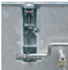
2. Københavnslås – en enkel og funktionsdygtig låsemekanisme kombineret med bøjle for panik-åbning.
