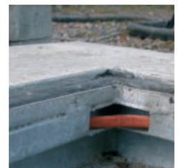
3. Värmekabel – skyddar mot frost och is.
