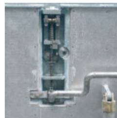
2. Köpenhamnslås – en enkel och funktionell låsmekanism kombinerat med bygel för paniköppning.
