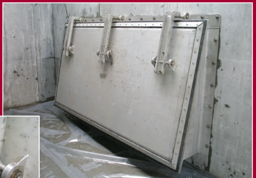
Flansch mit Bolzen für Justierung der Klappe
